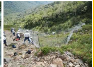
早池峰山の植生保護のための保護柵設置（遠野支署）
