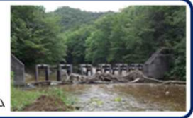
流木捕捉式治山ダム
