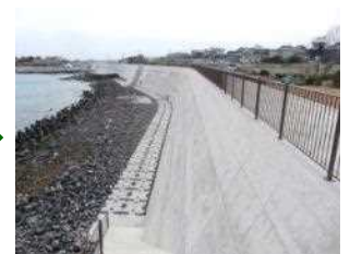
整備した防潮堤(H29:気仙沼市)
