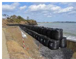
大型土のうによる仮設護岸工設置(H24)
