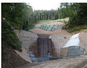
コンクリート谷止工 (秋田県上小阿仁村)
