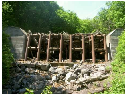
設置済みの流木捕捉式治山ダム(岩手県八幡平市)
