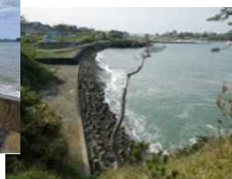
大型土のうによる仮設護岸工設置(H24)
