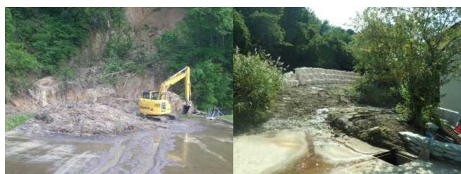
応急対策(左: 河道閉塞除去、右: 大型土のう設置) (平成30年8月豪雨: 山形県戸沢村等)
