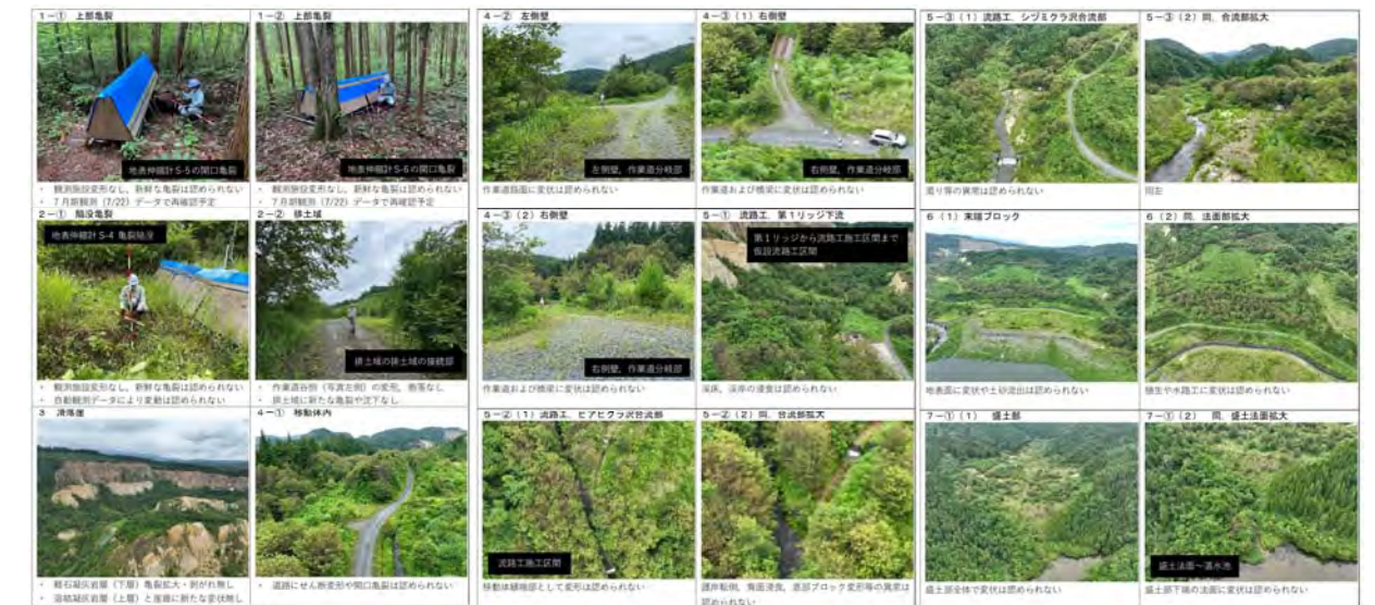
R4.7.19 多降水後の現地踏査(報告)の事例
