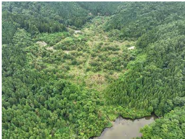
盛土部全体における変状の有無
