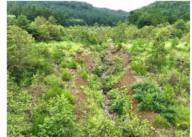
水路の底面洗掘や側面浸食の有無
