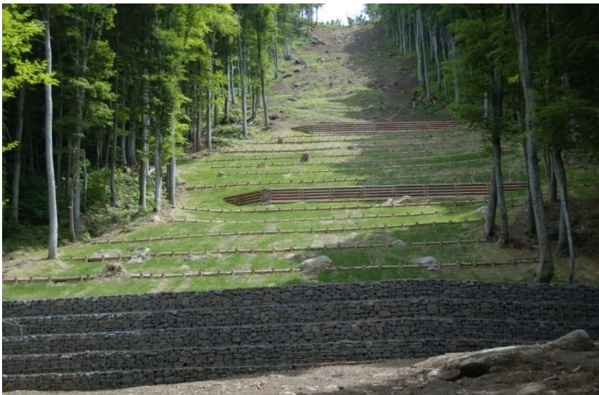
施行後（白雪川地区治山工事）
