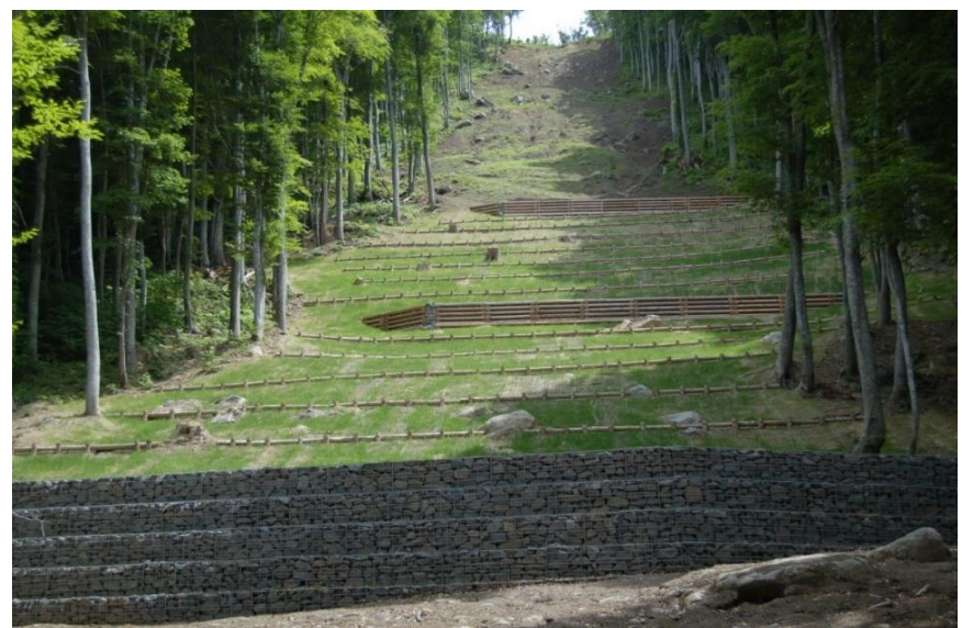
施行後(白雪川地区治山工事)
