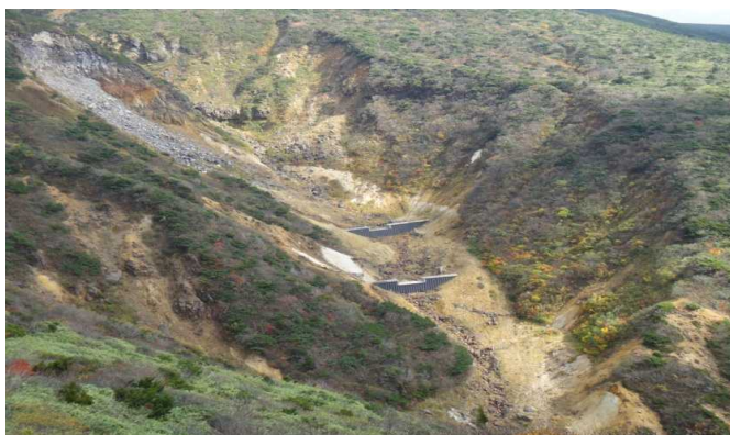
仙人沢治山ダムの遠景
