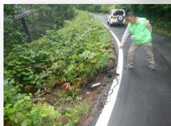
路肩の崩壊状況の調査
