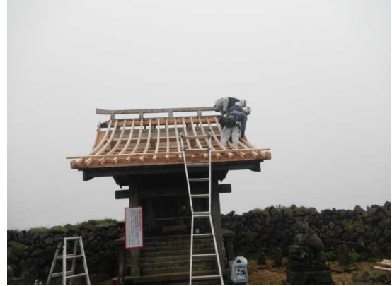
熊野岳 蔵王山神社の修理作業中
