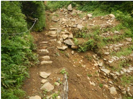
碓氷川コースの6月の雨で崩れた個所は修理済み
