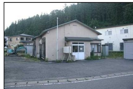
建設予定地（解体工事前）
