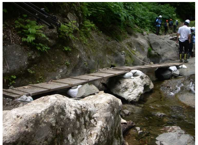
木の板を渡す簡易的な整備
