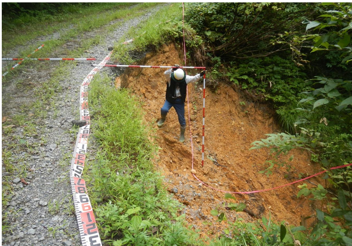
②1-2号箇所 近景(起点側より撮影)
