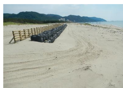
防風柵工 (風を弱め、植生回復を図る)
