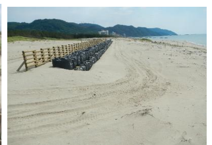
防風柵工 (風を弱め、植生回復を図る)
