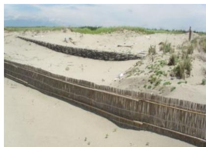
砂丘垣工・防浪垣工 (砂の移動を抑える)
