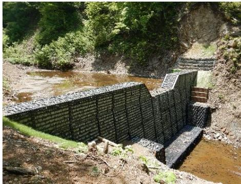
治山ダム(鋼製枠)施工状況
