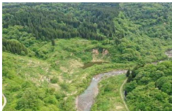
銅山川に面した地すべり末端部
