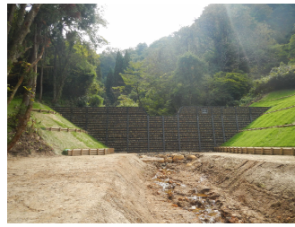
治山事業（溪間工）
