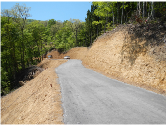
林業専用道（新設）
