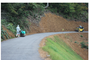
林道工事（※鉄鋼スラグ）
