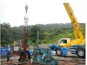
治山事業（鋼管杭工）
