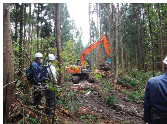
現場の安全点検①
