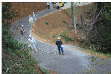
散水の作業 (㎡当たり 5ℓ)
