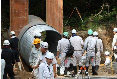
コルゲートパイプの点検（林道）
