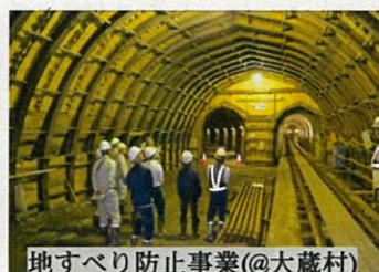
地すべり防止事業(@大蔵村)で施工した排水トンネル
