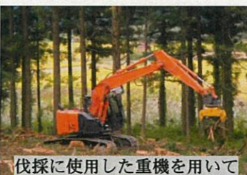
伐採に使用した重機を用いて地拵え(枝等の整理)を実施
