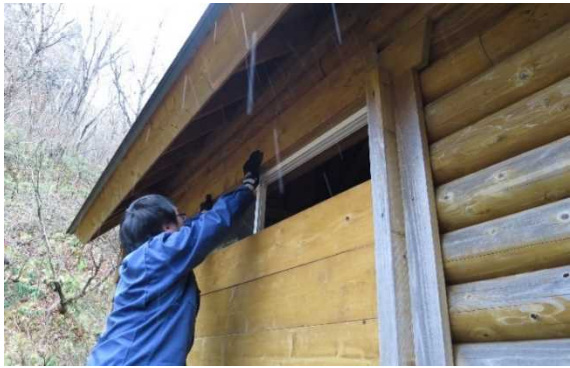
水沢巡視管理棟冬囲い
