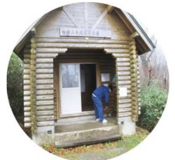
二ツ森巡視管理棟
