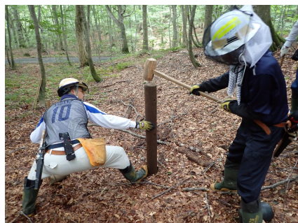
杭の打ち直し
