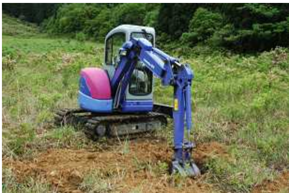
写真1 小型バックホーの植穴掘り
