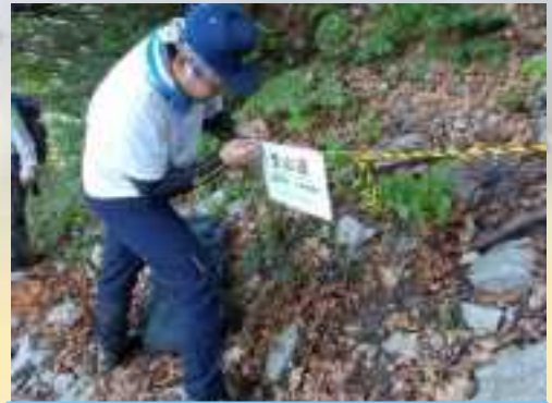
ショートカット規制注意標識取り付け作業
