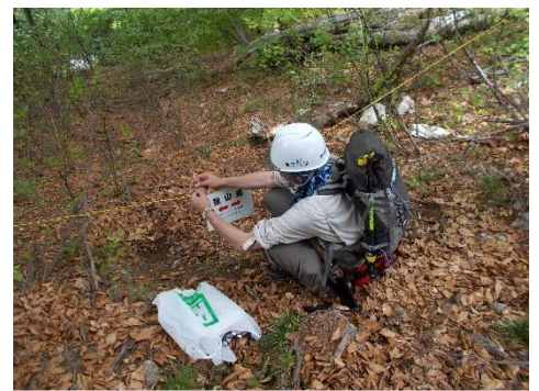
上下に設置し、崩れやすい法面を保護します
