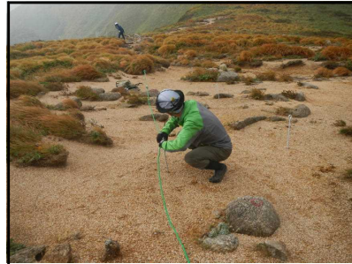
杭、ロープの設置
