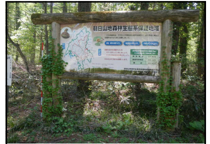
腐朽等が進んだ看板
