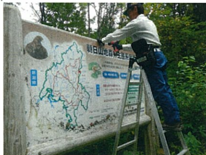
大型表示標識プレートの固定(南俣沢出合)
