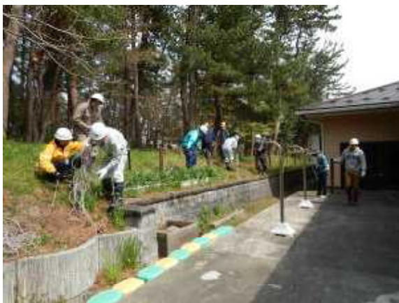
(杭を設置し、ロープを交換しました)
