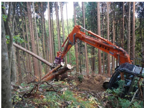
フェラーバンチャザウルスロボによる 路網作設のデモンストレーション
