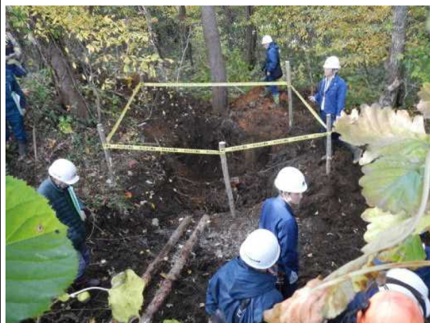
搬出路の改良状況の確認風景 (排水路の作設状況)
