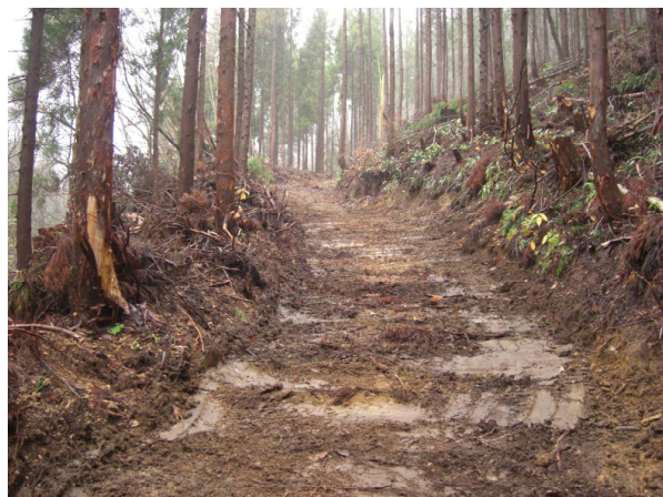
森林作業道の現況
