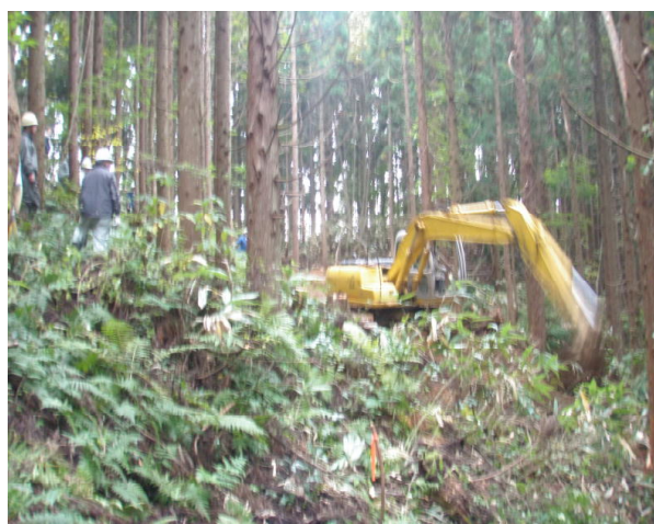
作設デモンストレーション
