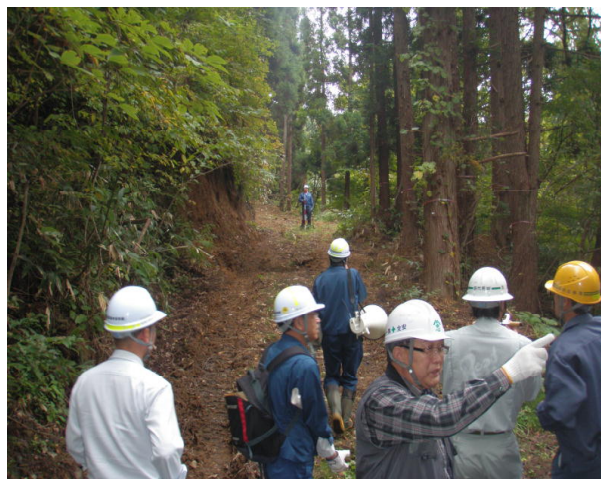
縦断勾配の測定実演
