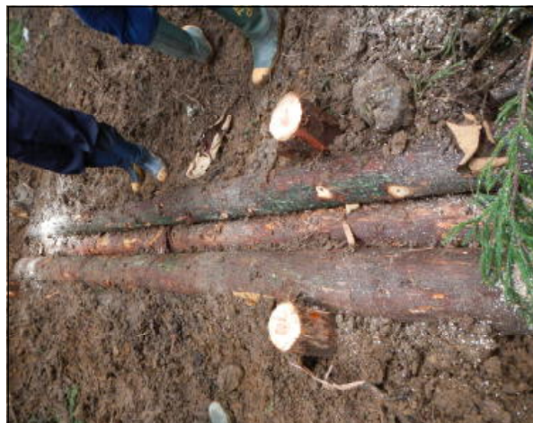
丸太による簡易横断工
