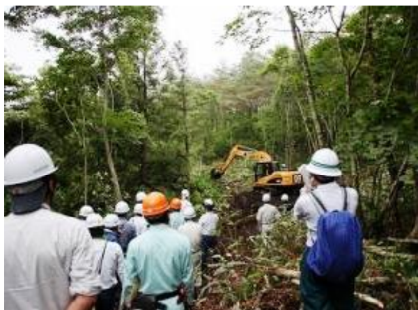
森林作業道の作設状況
