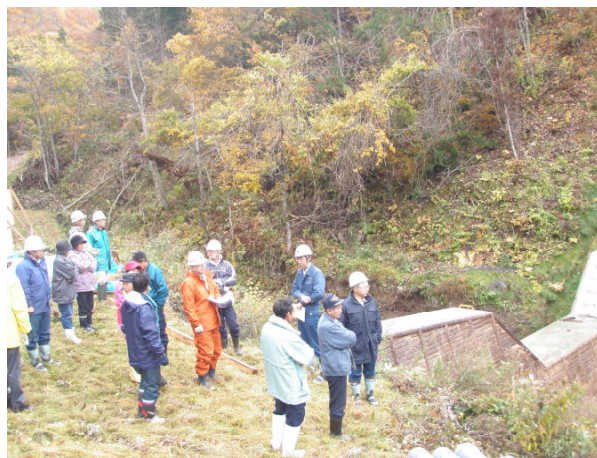
施工完了の治山ダム（国有林）
