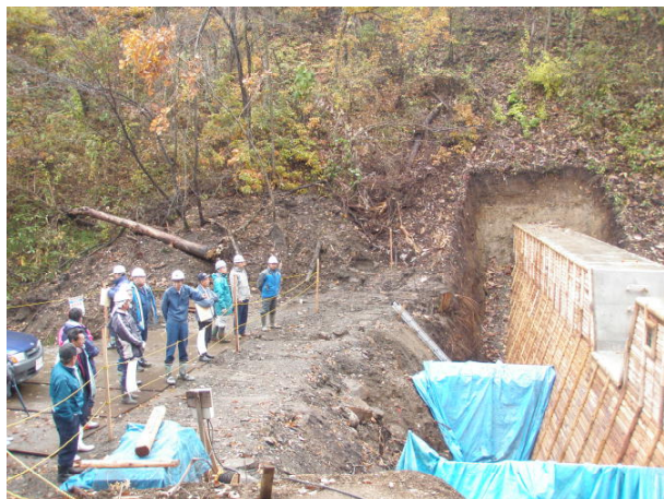
施工途中の治山ダム（私有林）
