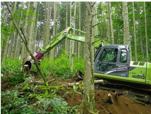
ザウルスロボによる作業道作設
