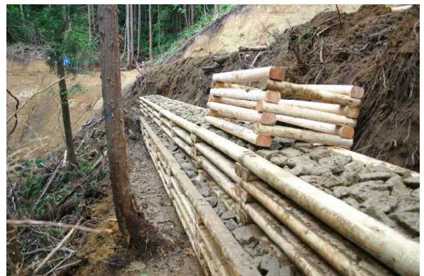
林道工事での木製布団籠（長格木枠工）組立、施工中の様子
