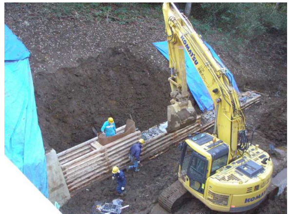
治山工事での木製布団籠の使用
