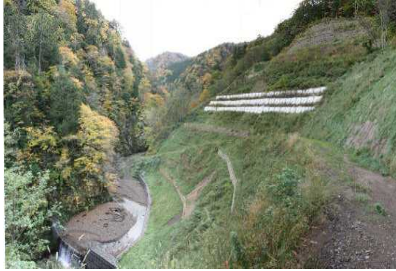
完成した施設の全景
