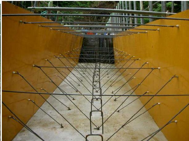
山形県産材土木用型枠合板の使用状況（藁口治山工事）
