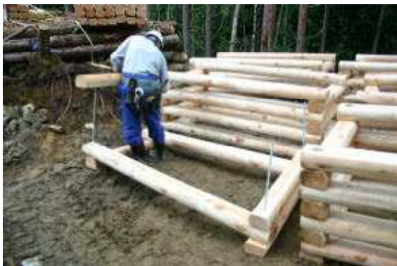
林道工事での木製布団籠（長格木枠工）組立、施工中の様子
