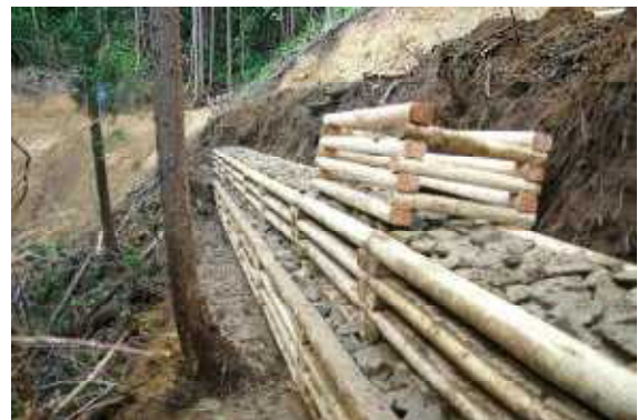
林道工事での木製布団籠（長格木枠工）組立、施工中の様子
