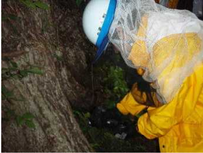
注入前の穿孔作業
