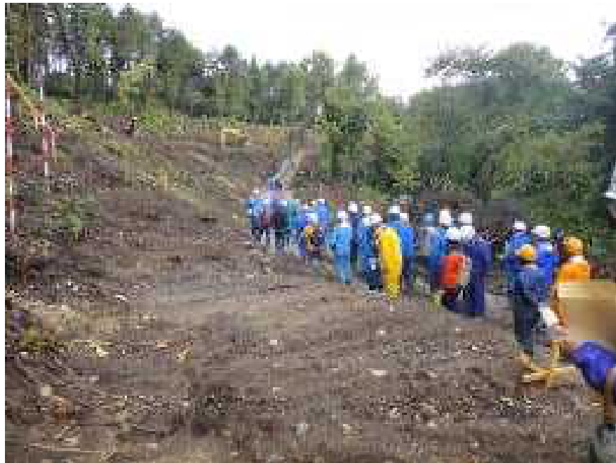
林業専用道開設工事箇所での検討会風景
