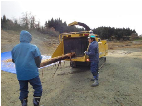
破砕機へ木材の投入
