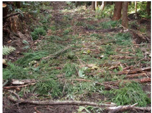
丸太を利用した作設した洗い越し
