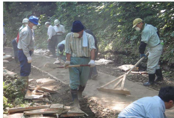
遊歩道整備作業風景 (H23. 9. 16)
