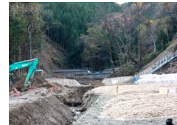
谷止工 工事状況 (平成21年11月4日)
