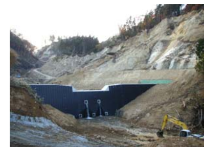
谷止工施工状況(平成21年10月23日)
