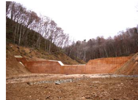
谷止工施工状況(平成21年11月17日)
