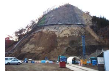
吹付砕工施工状況(平成21年11月4日)
