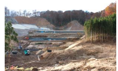
山腹工施工状況(平成21年11月4日)
