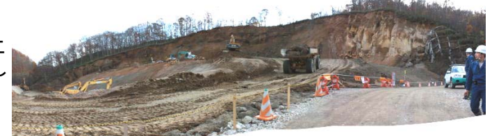
切土工施工状況(平成21年11月4日)
