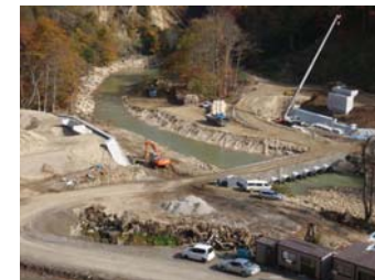
工事状況全景(平成21年10月30日)
