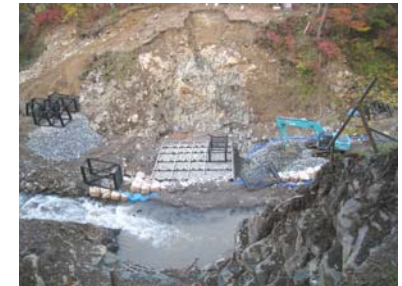
谷止工施工状況(平成21年10月22日)
