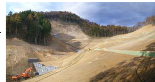
山腹工施工状況(平成21年11月4日)
