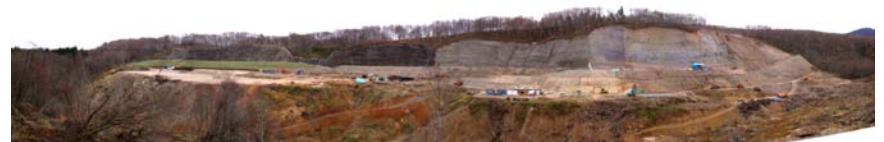
施工地の全景(平成21年11月17日)
