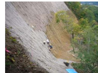
上部法面伏工施工状況 (平成21年10月1日)
