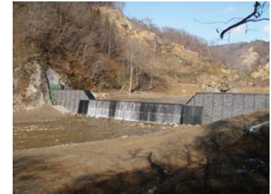
床固工完成(平成21年11月24日)
