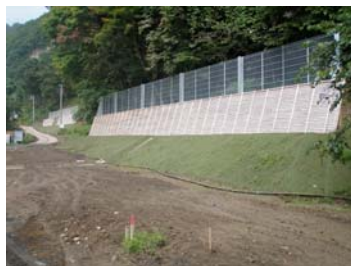
土留工(完成:平成21年9月15日撮影)
