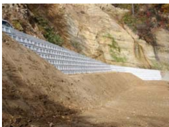
9号工事状況(平成21年10月21日)
