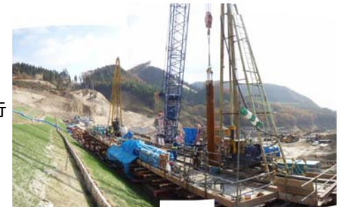
杭打工施工状況(平成21年10月28日)
