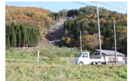
山腹工施工状況(平成21年11月6日)
