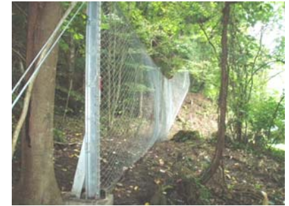
落石防護柵の設置(平成21年8月28日)
