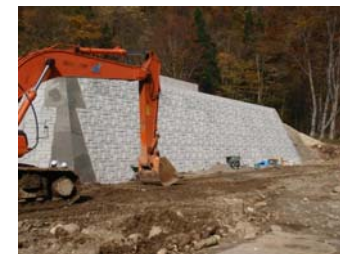
右岸護岸工設置状況 (平成21年10月30日)
