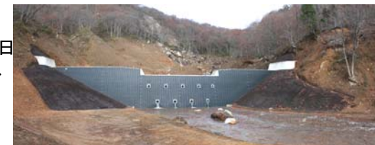
谷止工 完成(平成21年11月4日)
