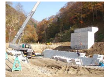
左岸護岸工設置状況 (平成21年10月30日)
