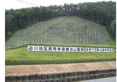
吹付砕工 (完成:平成21年8月4日)
