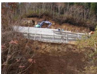
11号工事状況(平成21年11月2日)
