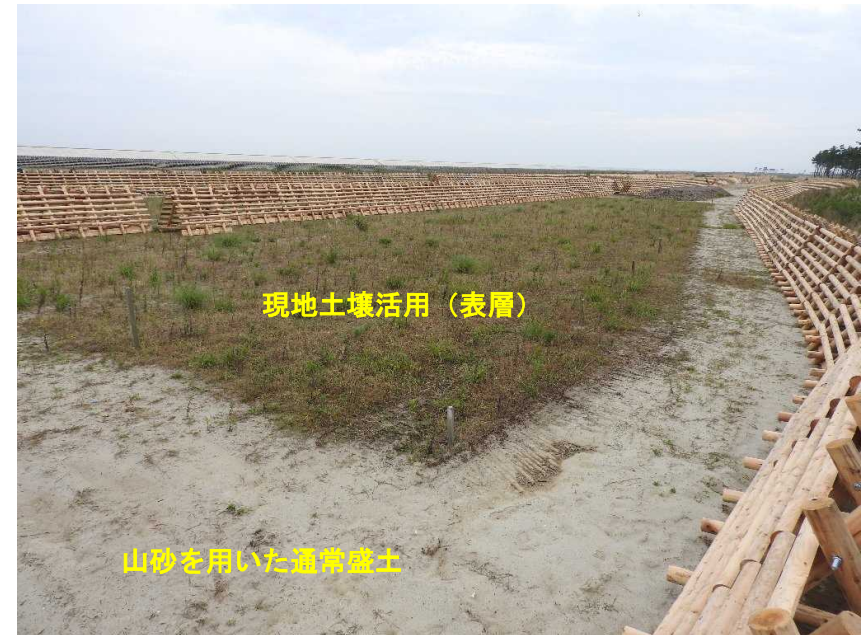
【盛土施工の約1年半後の植生被覆状況（表層試験地）】
