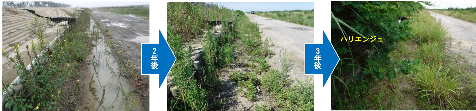
2c.作業道沿い連続性確保区域（左：2015.9.11、中：2017.7.26、右：2020.8.8の撮影）
