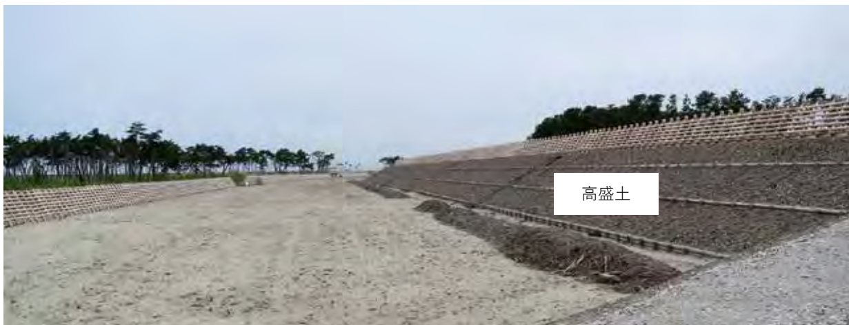
防災機能を補填した高盛土の例（仙台市宮城野区 平成 30 年）
