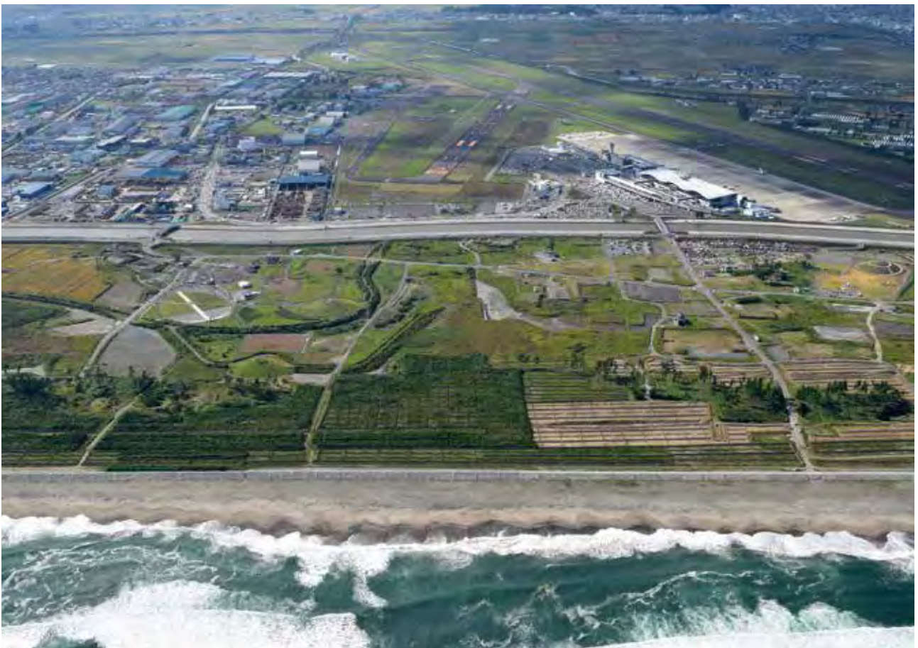
復旧事業完了段階（令和 2 年 10 月 14 日）
