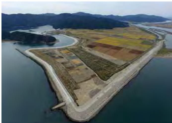
復旧事業完了状況（石巻市長面 令和 2 年 10 月）／石巻市提供
