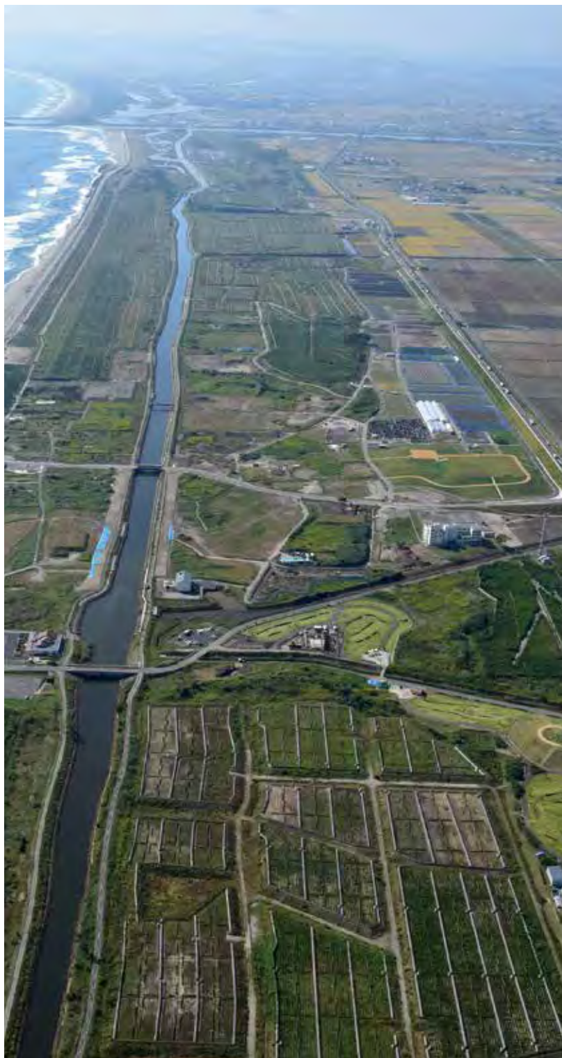
復旧事業完了段階 (令和 2 年 10 月 14 日)
