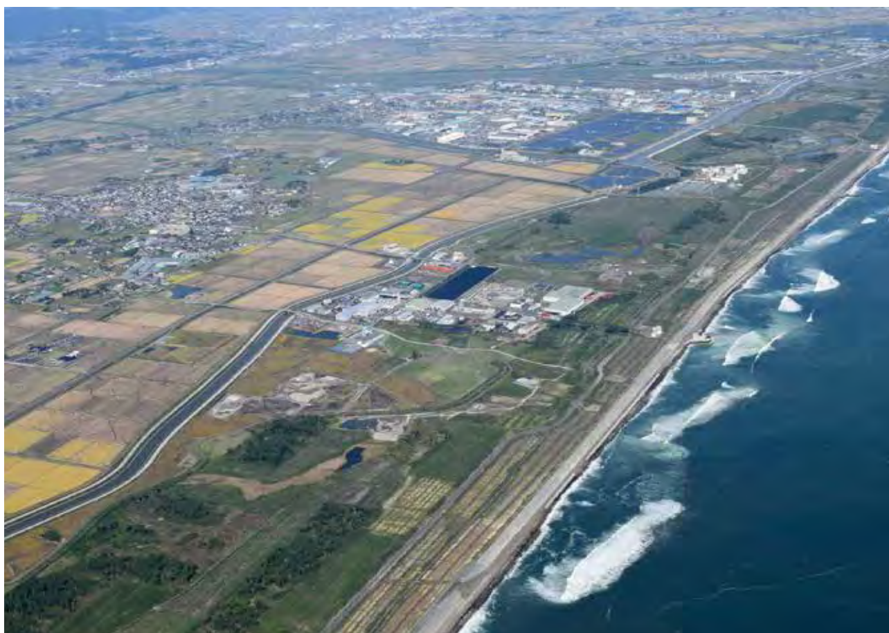
復旧事業完了段階（令和 2 年 10 月 14 日）
