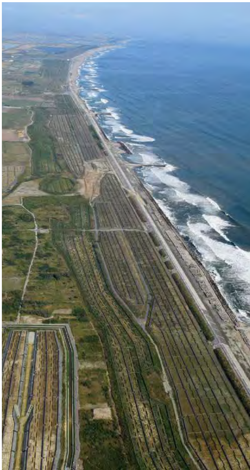
復旧事業完了段階 (令和 2 年 10 月 14 日)
