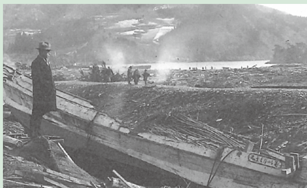
昭和8年昭和三陸津波の被害状況（大船渡市）
