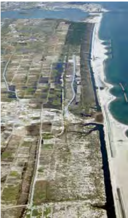
東日本大震災後 (平成 23 年 10 月)
