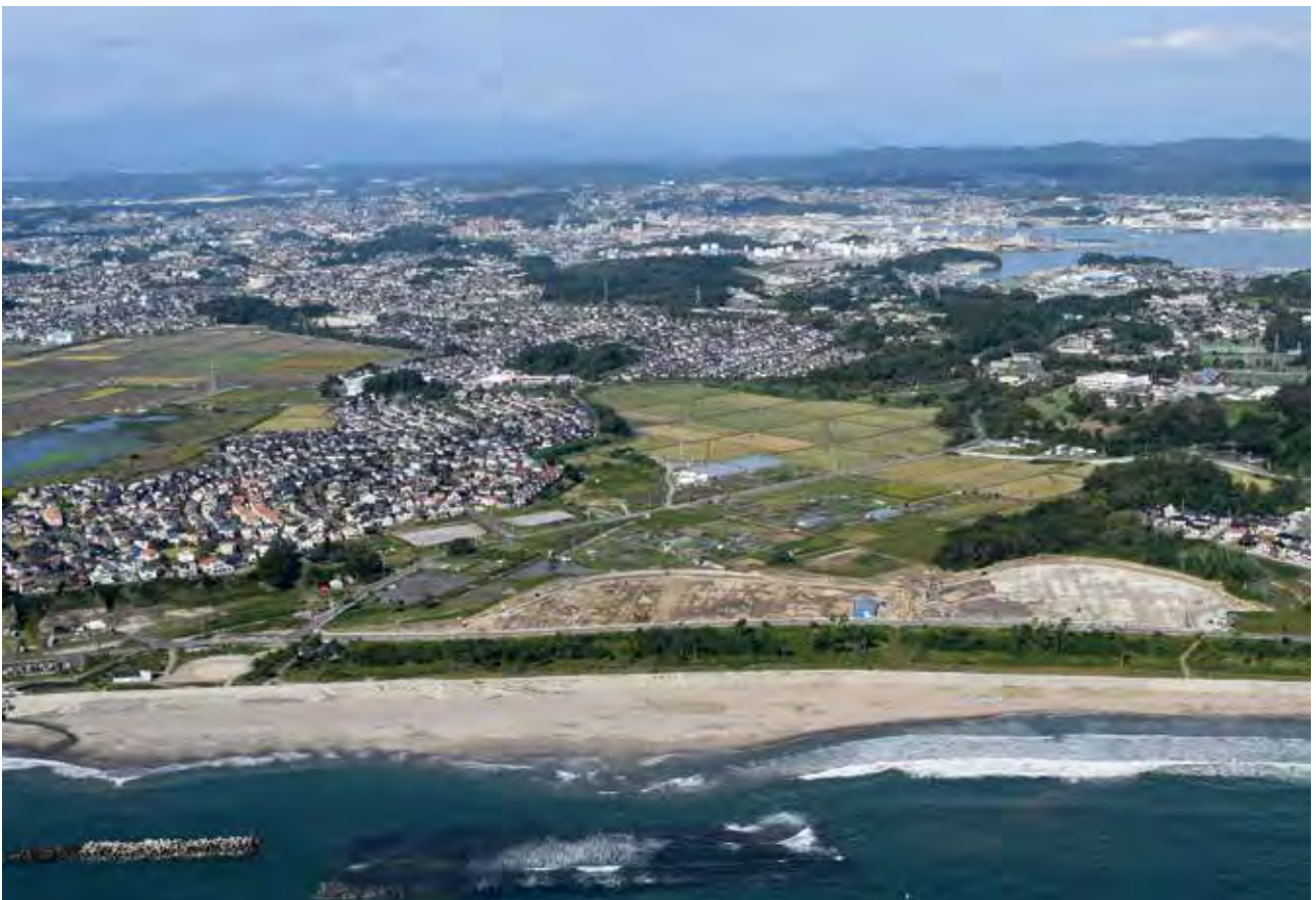
復旧事業完了段階（令和 2 年 10 月 14 日）
