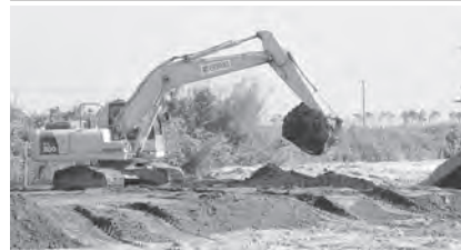
仙台市若林区でがれきの再生資材による盛り土が開始された
