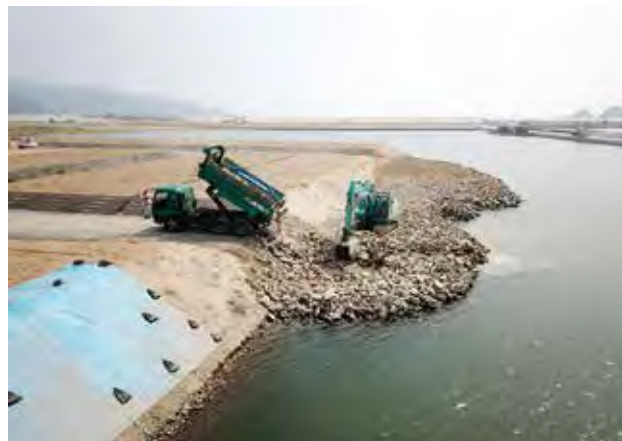
捨石施工状況（石巻市長面）
