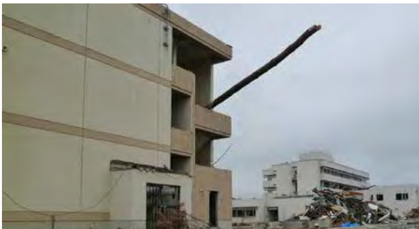
幹折れ被害木の流失事例（岩手県陸前高田市）
