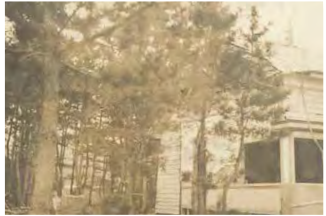
海岸防災林の減災効果により倒壊を免れた建物（昭和三陸地震津波直後の岩手県高田松原）
