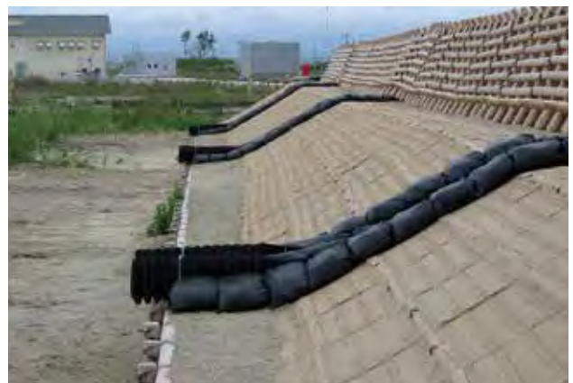
法面の U 型水路工（約 30m ピッチで配置）
