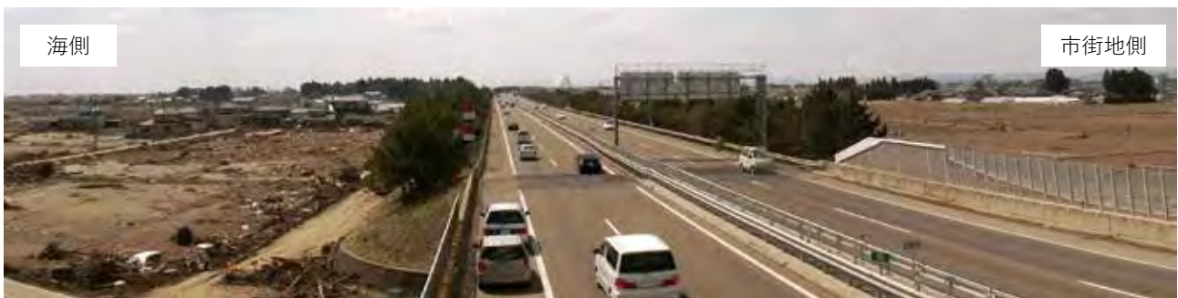
被災直後の仙台東部道路 仙台若林 JCT～名取 IC 間（出典：東北地方整備局 HP）
