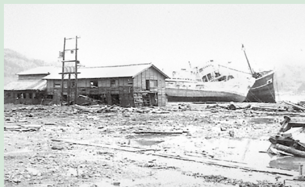
昭和35年チリ地震津波の被害状況（大船渡市）
