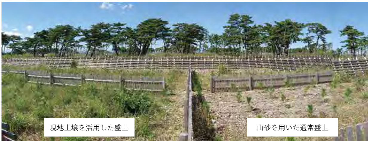
現地土壌を活用した保全対策の例（仙台市宮城野区 平成 30 年）
