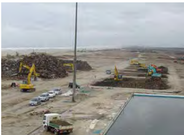
津波堆積土の選別状況（名取市）
