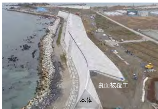
「粘り強い構造」の防潮堤施工状況（気仙沼市岩井崎）
