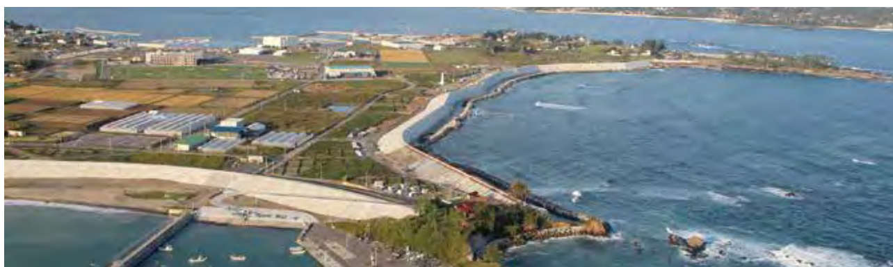
民有林における復旧状況（気仙沼市 御伊勢浜海岸（左側から中央）と岩井崎海岸（中央から右））
