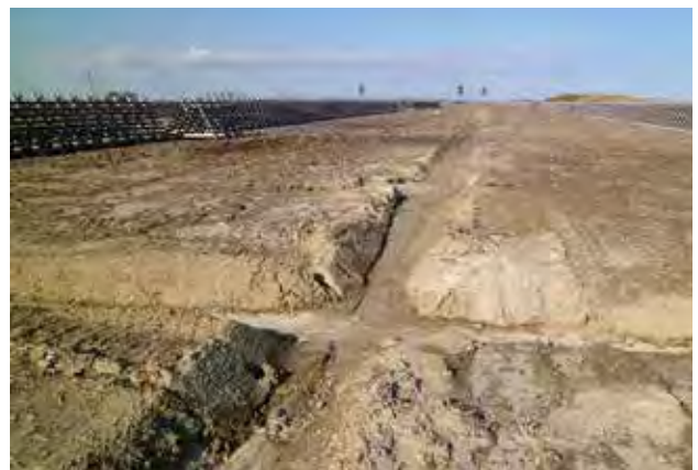
植栽面に設置した素掘水路工
