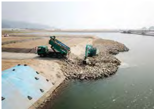
捨石施工状況（石巻市長面）
