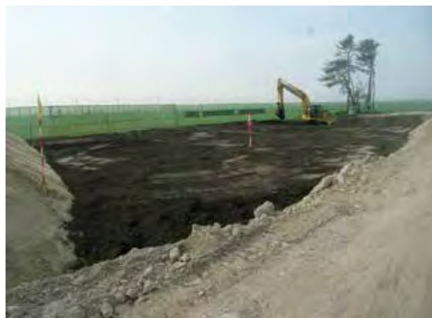
津波堆積土を用いた盛土施工状況（仙台市）
