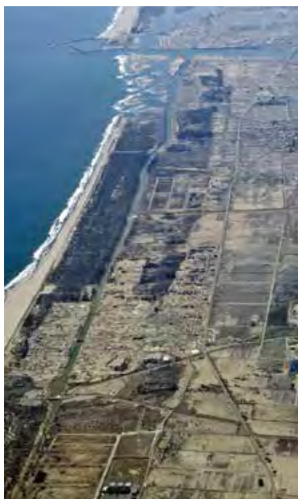
東日本大震災直後 (平成 23 年 4 月 17 日)
