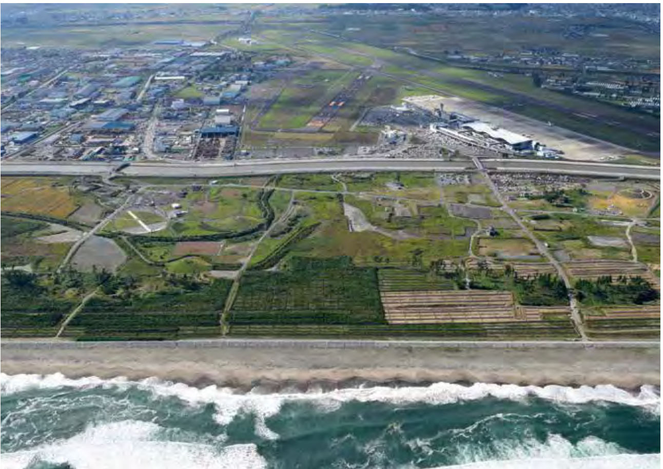
復旧事業完了段階（令和 2 年 10 月 14 日）
