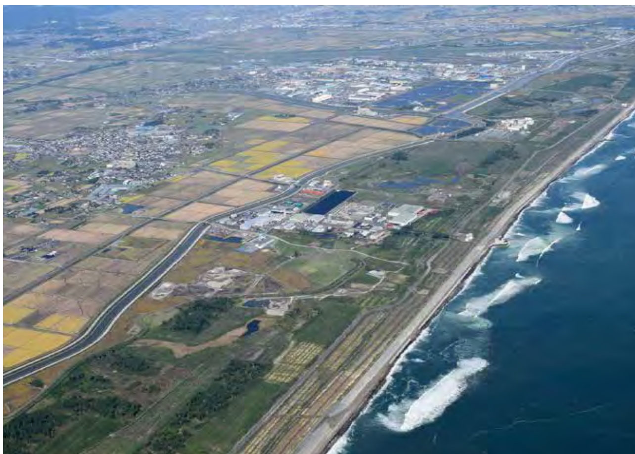
復旧事業完了段階（令和 2 年 10 月 14 日）
