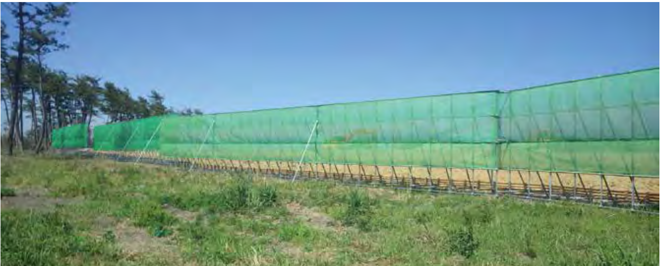
仮設防護柵工（防塵ネット）
