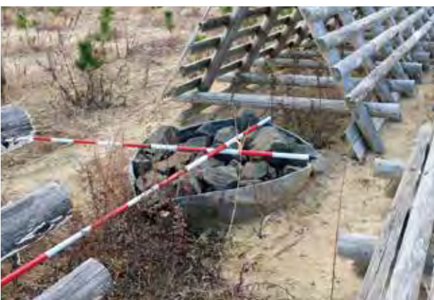
素掘水路工の途中に設置した縦暗渠工
