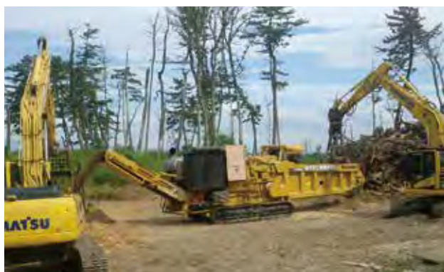
被害木のチップ化作業
