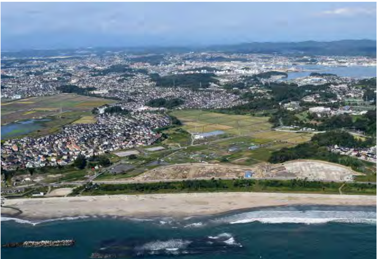
復旧事業完了段階（令和 2 年 10 月 14 日）
