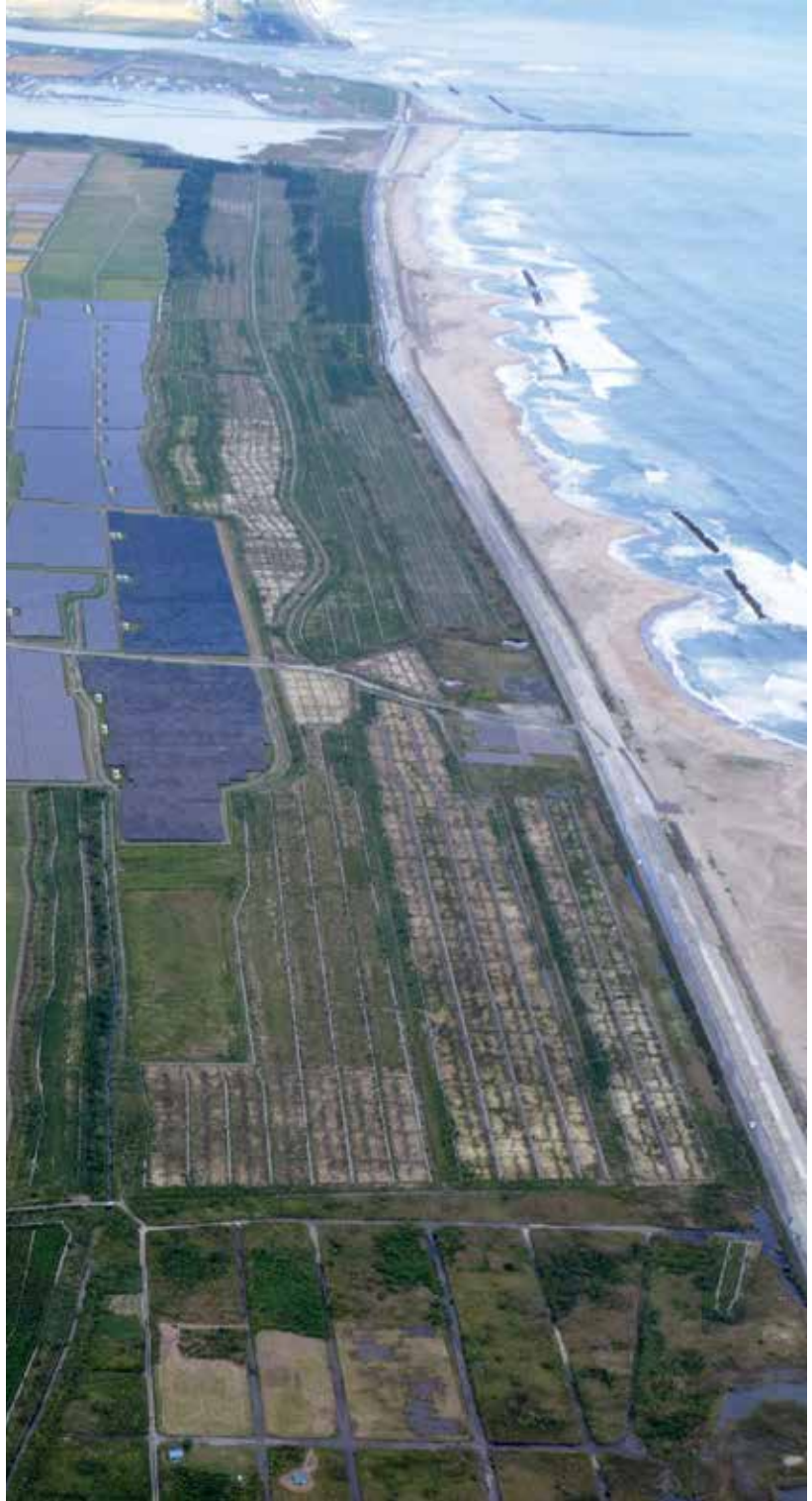
復旧事業完了段階（令和 2 年 10 月 14 日）
